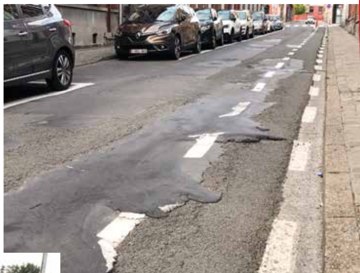
La rue du Luxembourg a subi un lifting partiel juste avant la rentrée.
