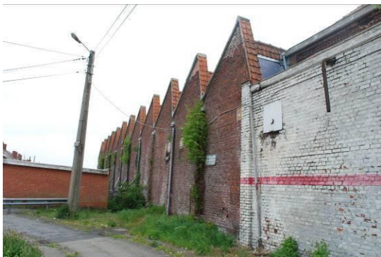
Figure 75 : bâtiment industriel au Sud-Ouest de la rue Couturelle (JNC AWP)
