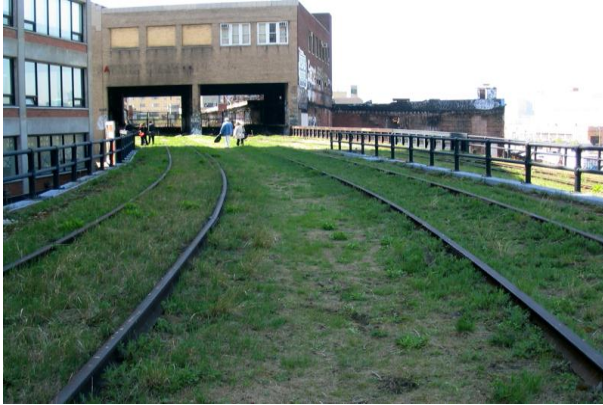
Figure 58 : ancienne ligne de chemin de fer avant les travaux d'aménagement du « High Line Park » (Source : internet)
